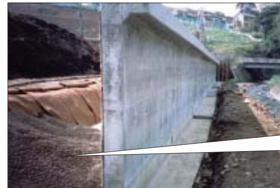
L型擁壁設置工事(神奈川県秦野市)
