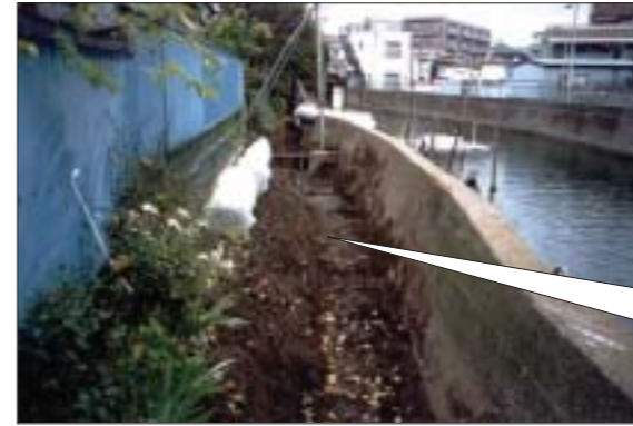
内川防災工事(東京都第二建設事務所)
