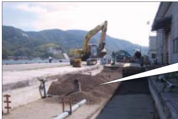
外港昭北地区岸壁(-9m)工事(境港管理組合)
