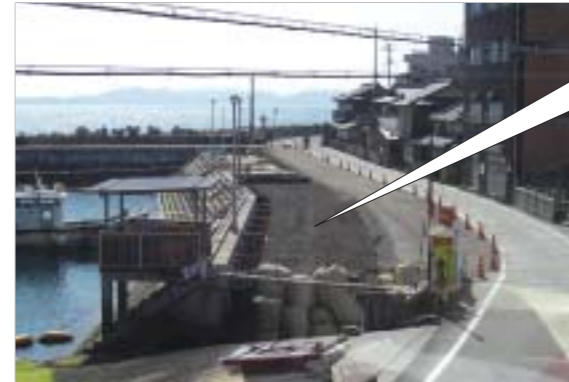
L型擁壁設置工事(神奈川県秦野市)
